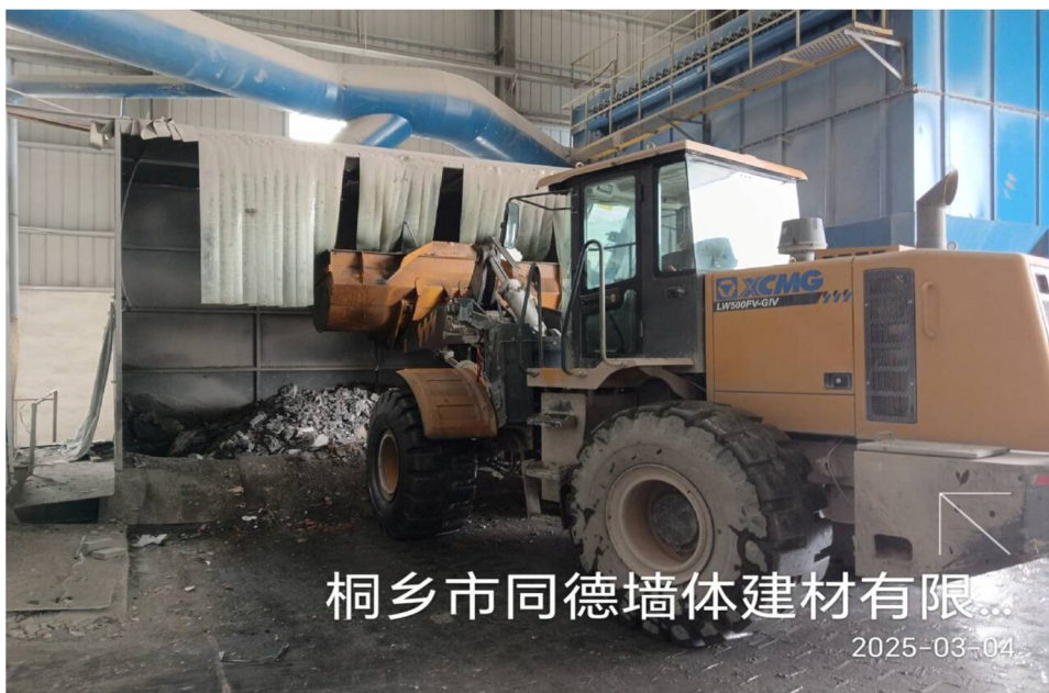
铲车上料岗位照片
