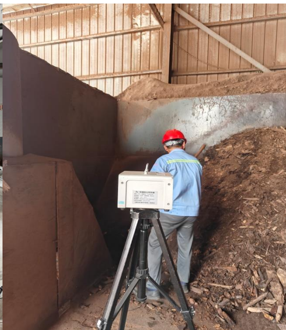
锅炉房投料巡检岗位
