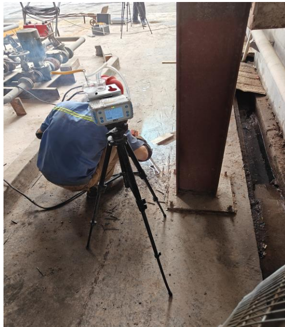
机修车间电焊岗位
