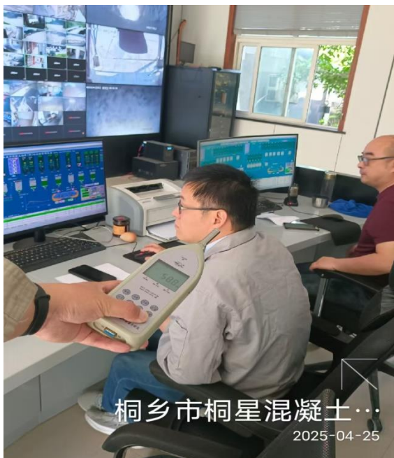
搅拌楼中控室岗位
