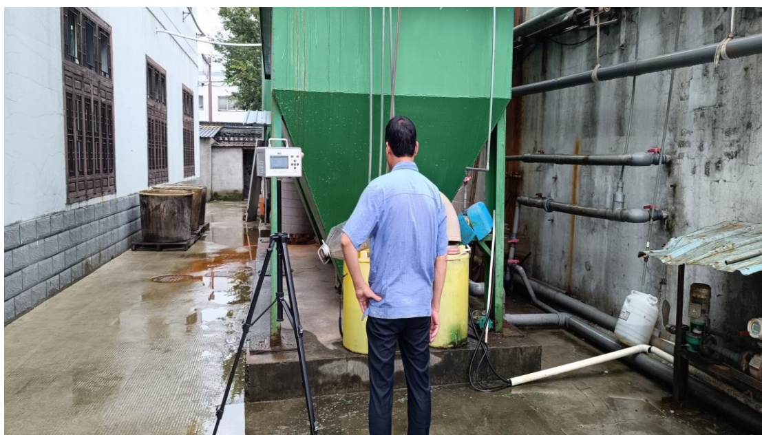
污水处理站投料岗位
