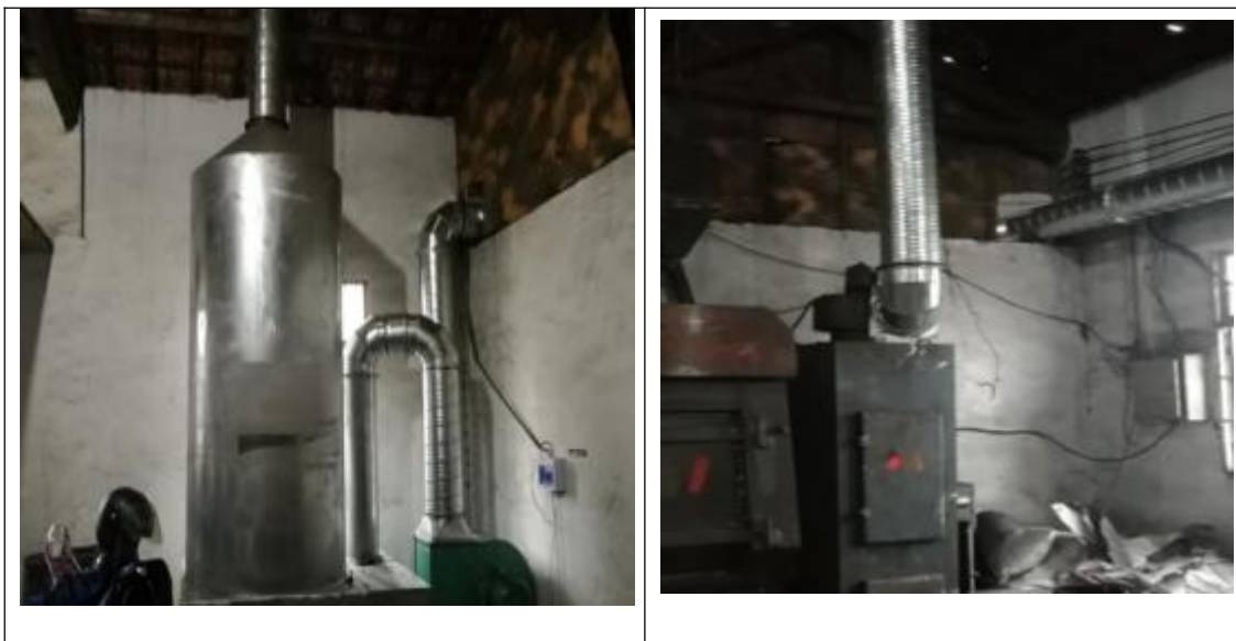
图 4-4 企业废气治理现场相关照片
