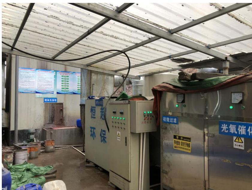
图 4-4 喷漆废气处理设备
