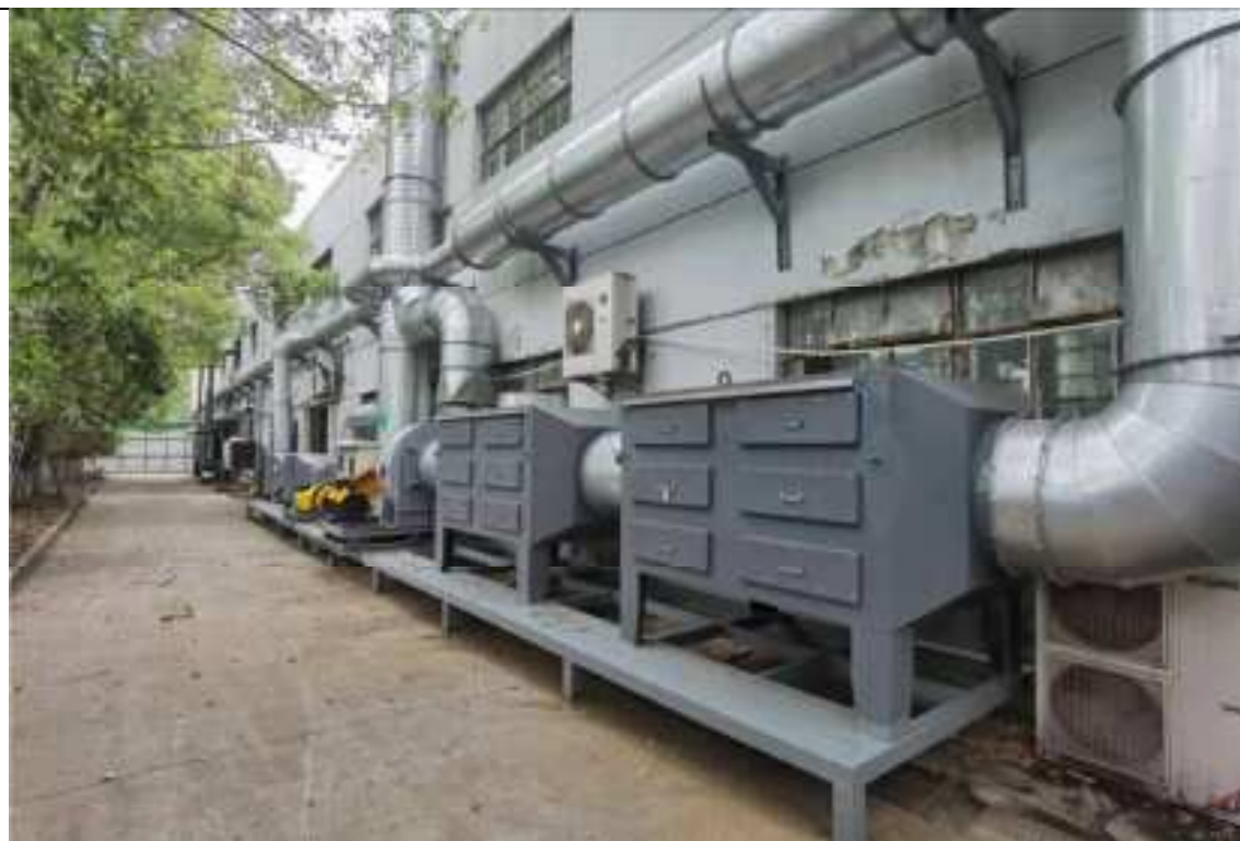
塑料轴承加工（混料、干燥、注塑）废气处理设施（左侧）及碳氢清洗废气处理设施（右侧）
