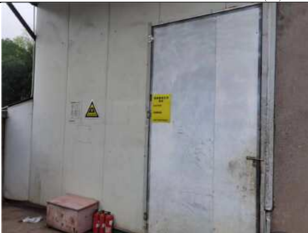
危废仓库外部照片
