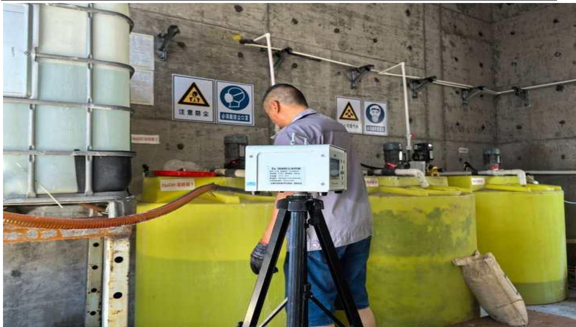
污水站加药岗位
