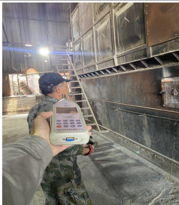
锅炉房锅炉岗位
