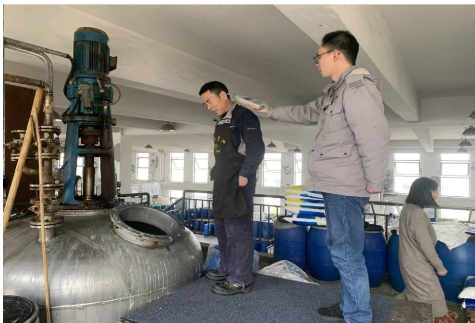
生产车间-搅拌岗位
