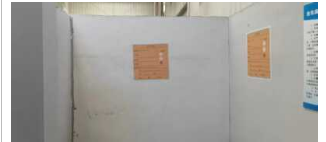
危险固废仓库内部
