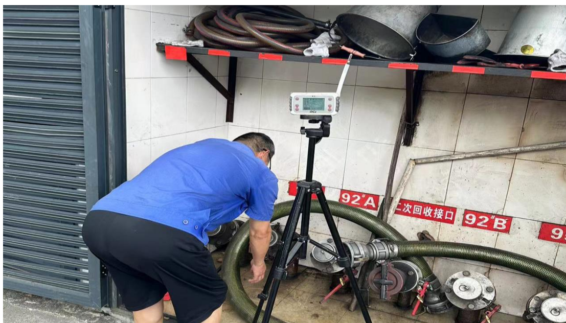
卸油单元卸油岗位
