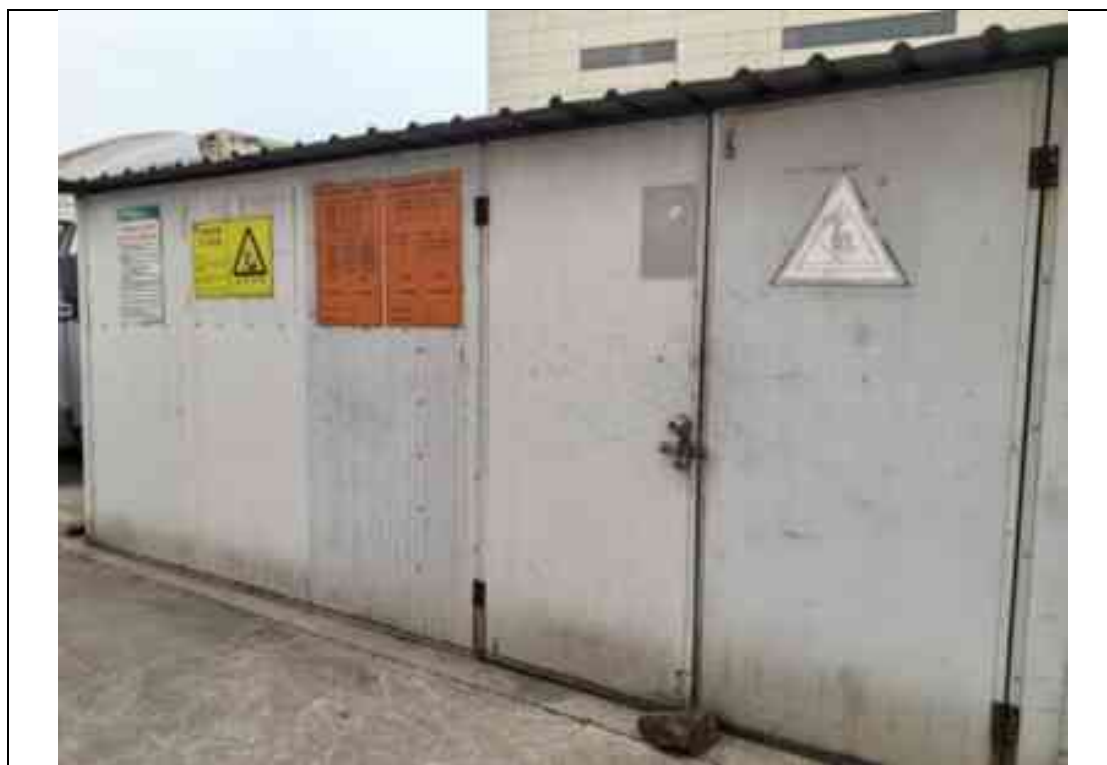
危废仓库外部照片
