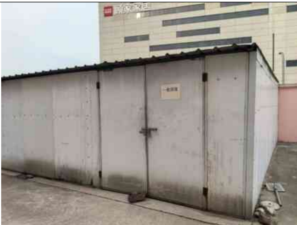
一般固废仓库外部
