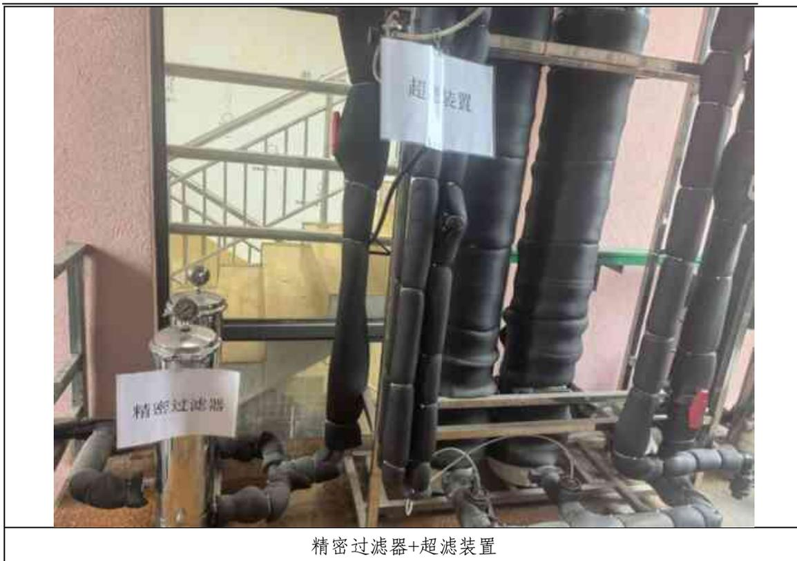
精密过滤器+超滤装置
