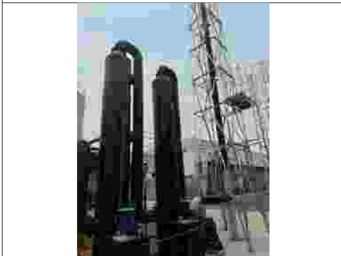
污水站废气处理设施（次氯酸钠喷淋+水喷淋）
