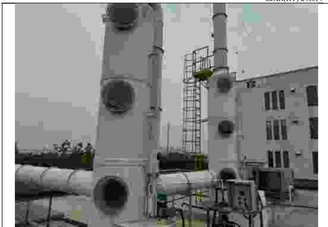
危废仓库废气处理设施（次氯酸钠喷淋+水喷淋）
