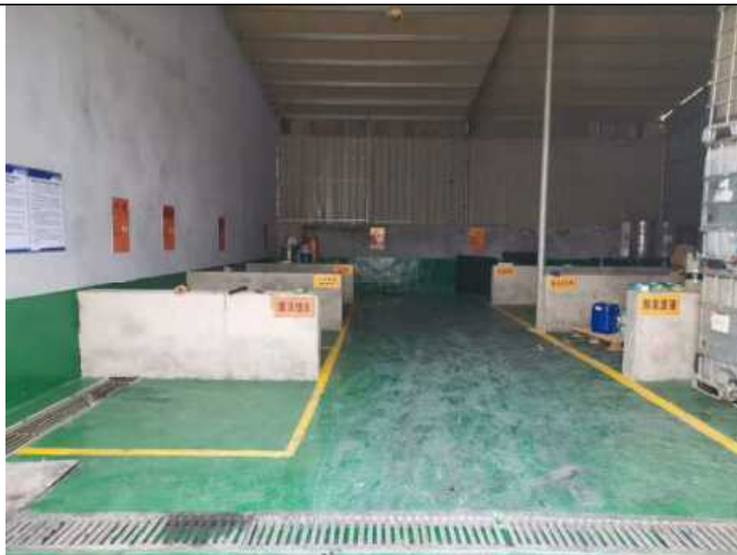
危废仓库内部
