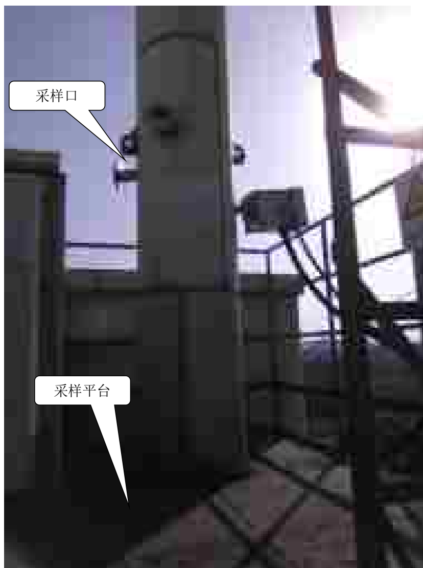
图 4.1-12 催化氧化装置排气筒
