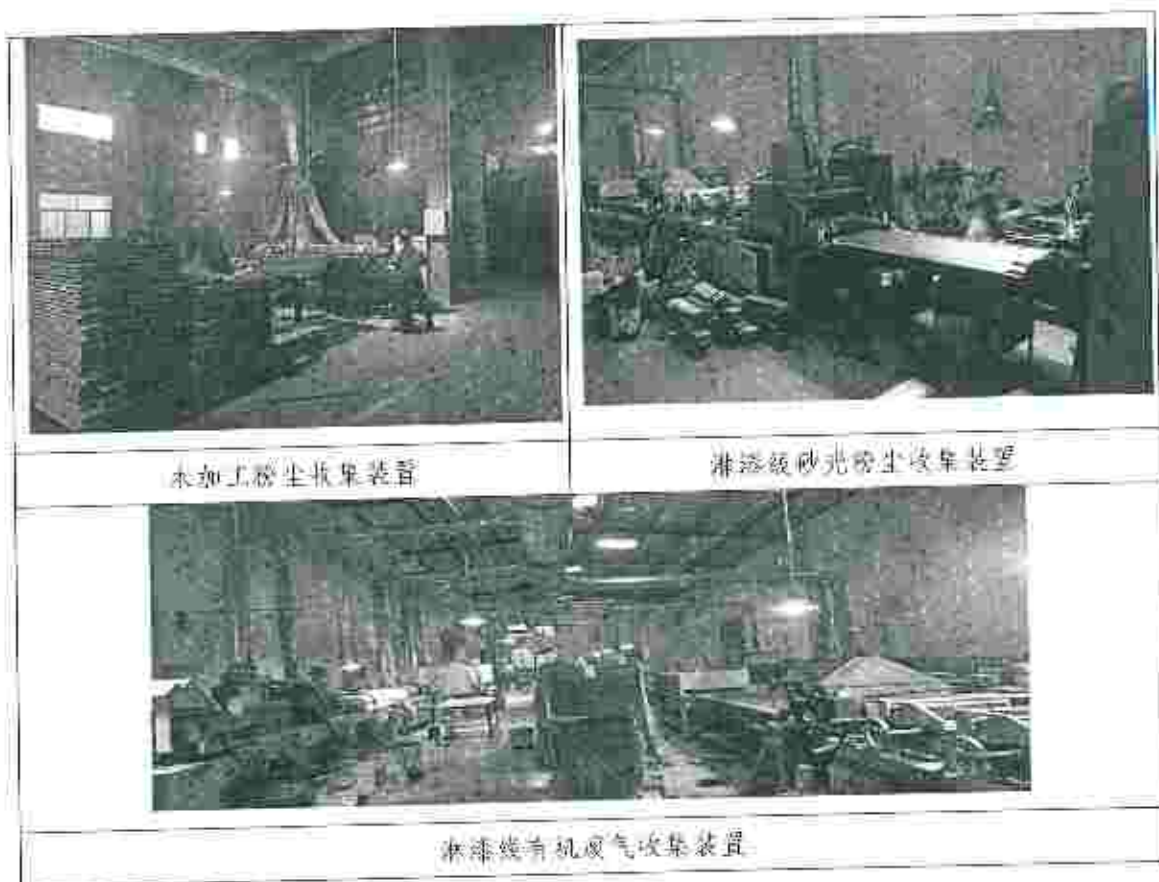
图 4-5 企业废气治理现场相关照片
