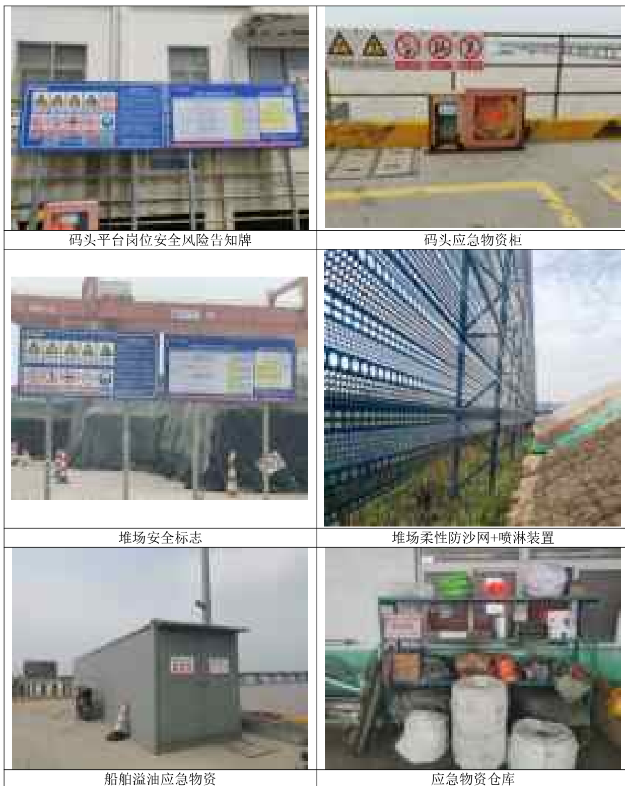
图 15.2-1 应急设施照片
