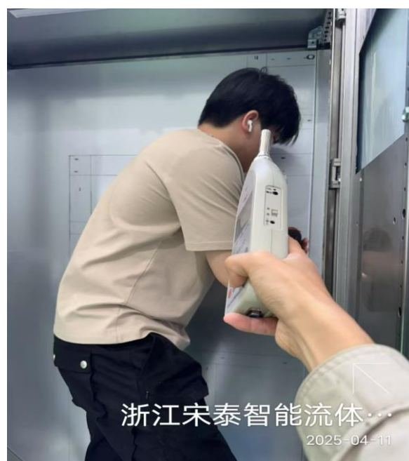
2 楼生产车间电柜安装岗位
