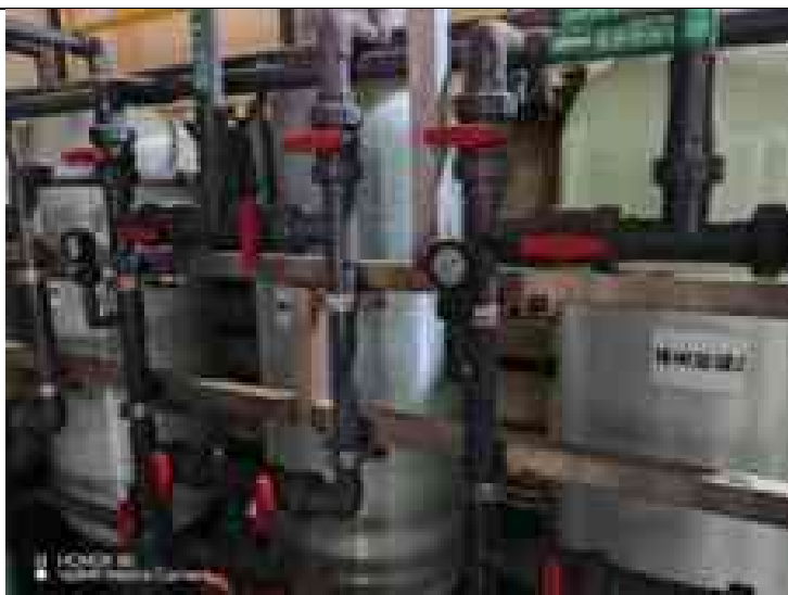
含镍废水：砂滤器+二级树脂吸附
