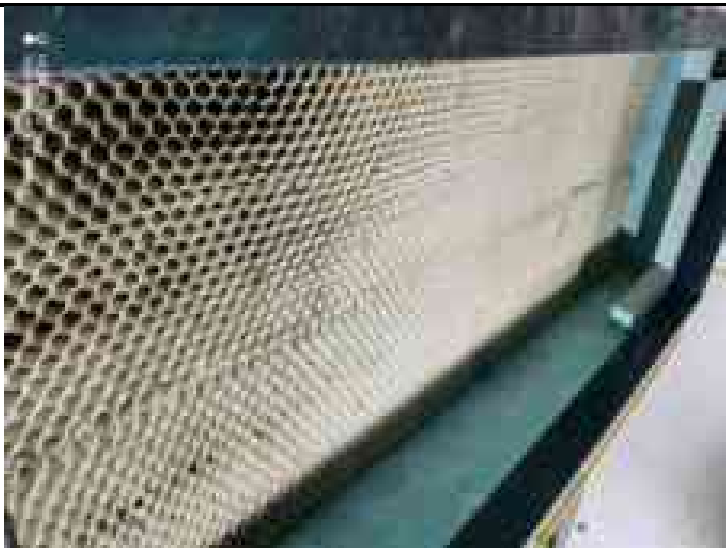
综合废水：沉淀池
