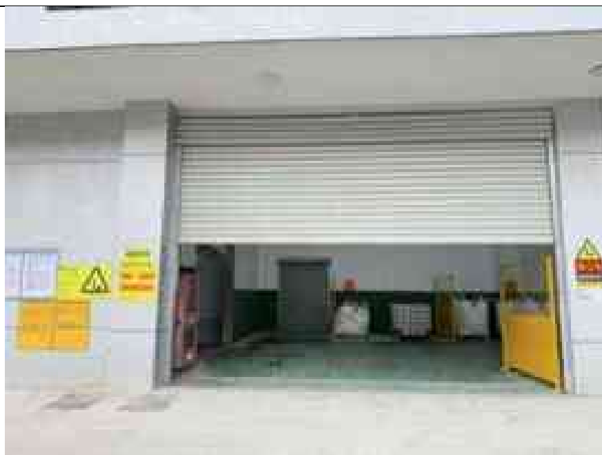
危废仓库外部照片
