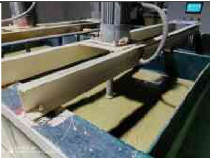
含镍废水：絮凝池
