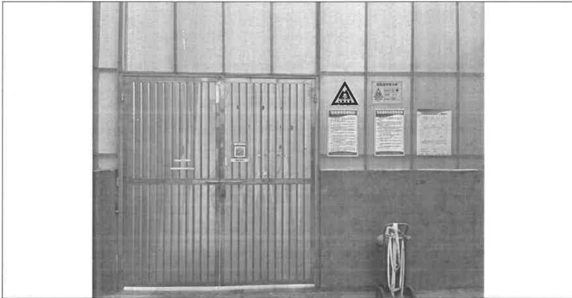
危废仓库外部
