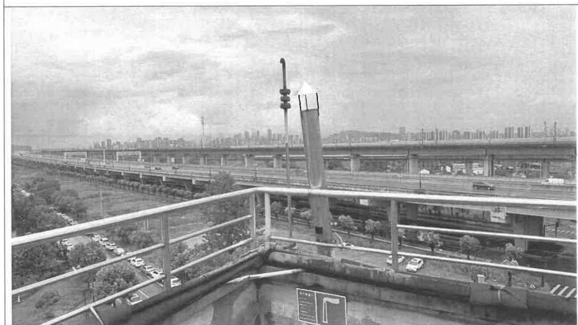
固色锅炉燃烧废气排放口
