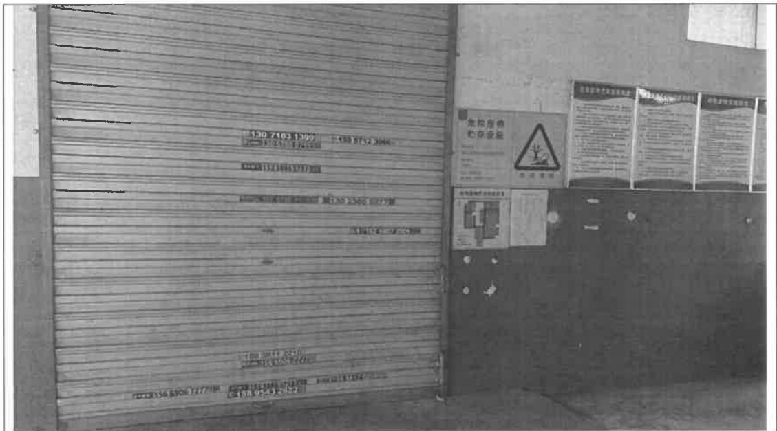
危废仓库外部
