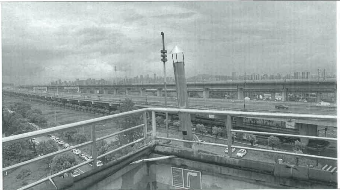
固色锅炉燃烧废气排放口
