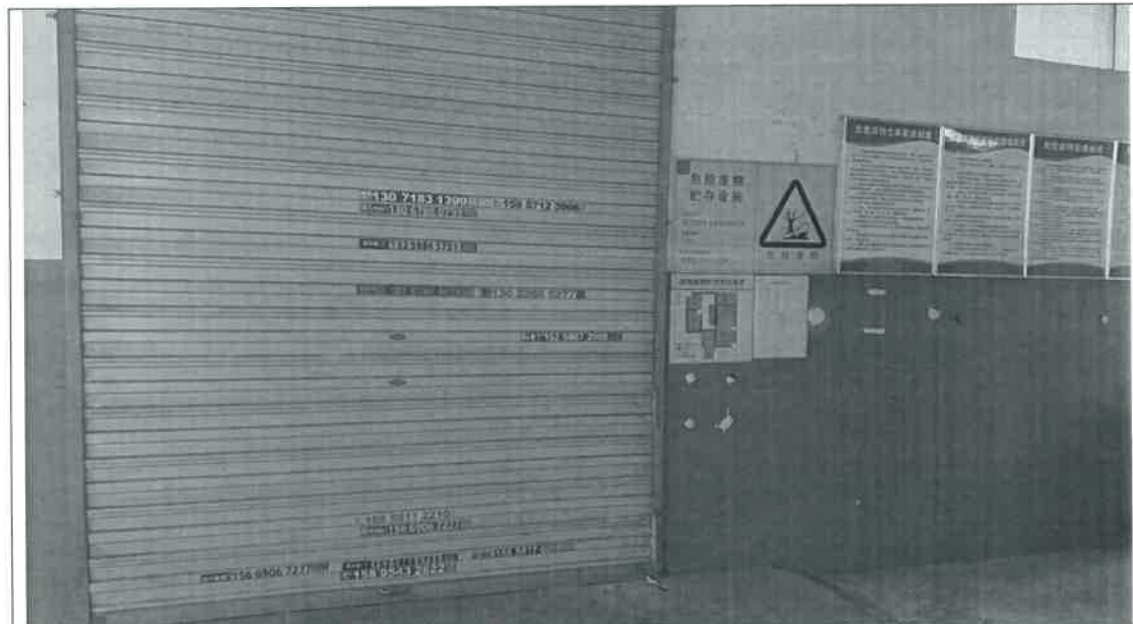
危废仓库外部
