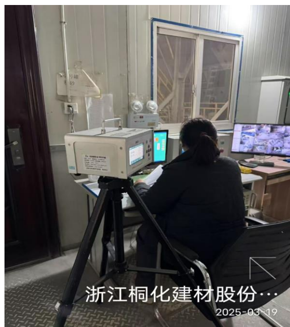
生产车间混料控制室岗位
