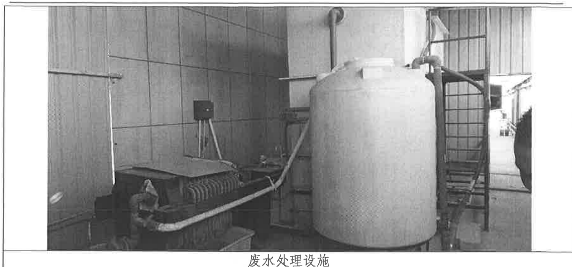
图 4-2 企业废水治理现场相关照片
