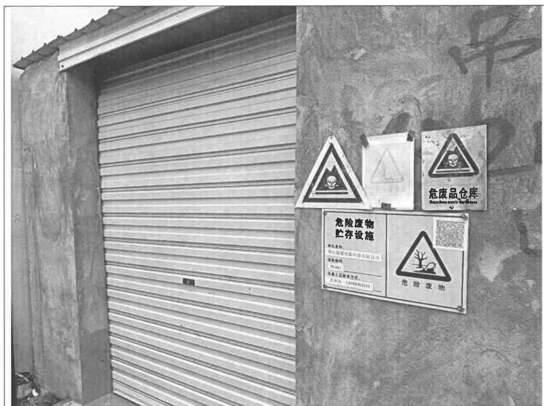
危废仓库外部
