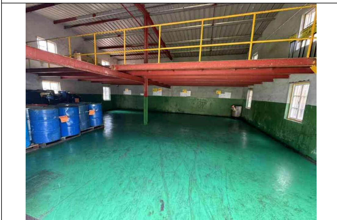
危废仓库内部
