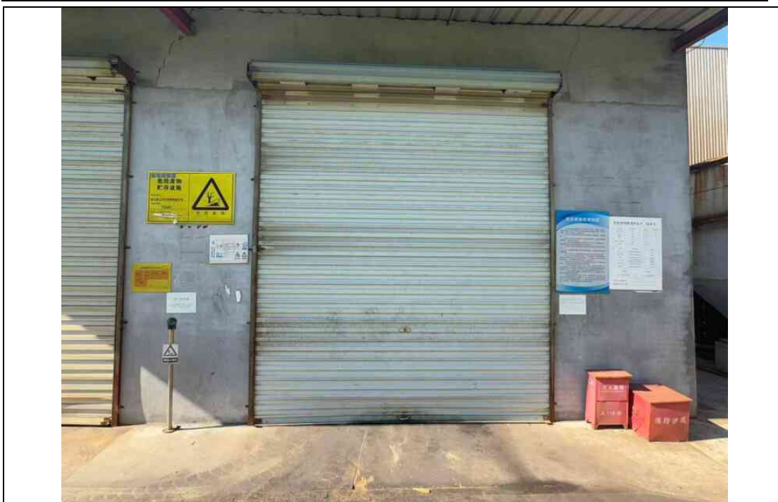
危废仓库外部照片
