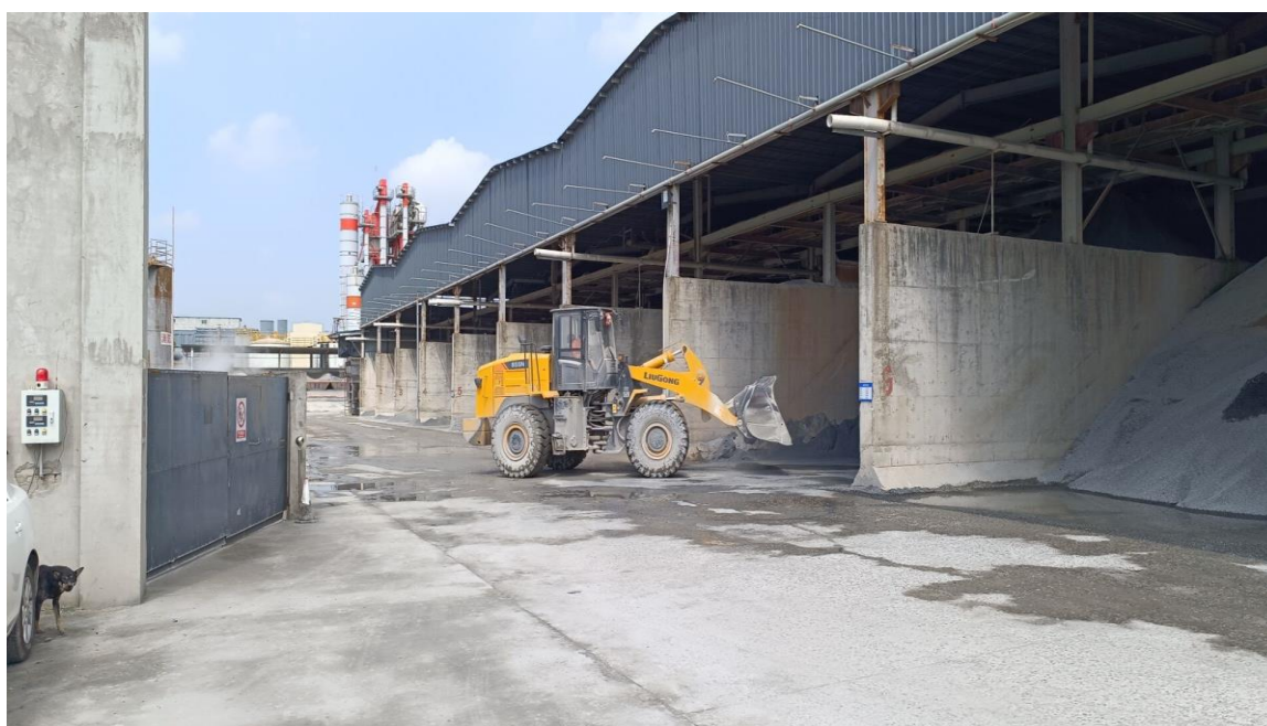
生产车间铲车上料岗位
