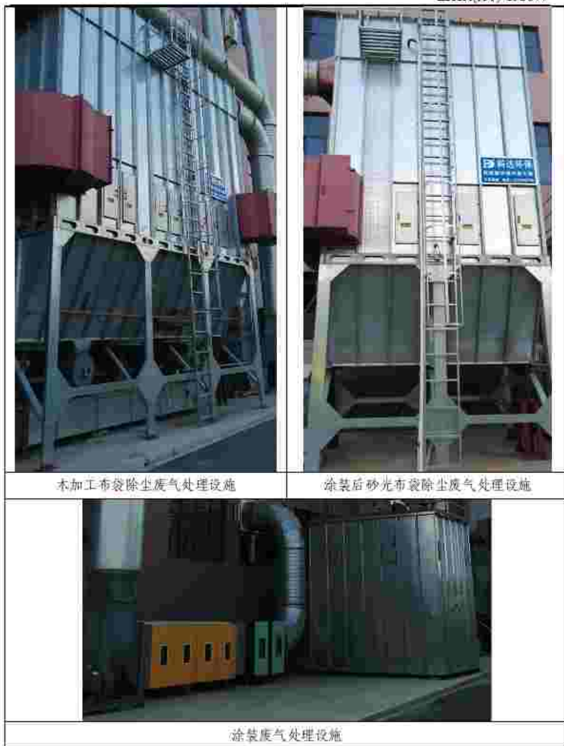
图 4.3 废气处理设施图
