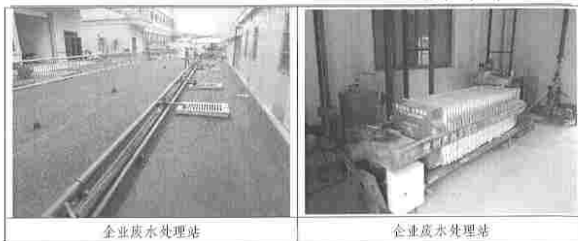
图 4-2 企业废水治理现场相关照片
