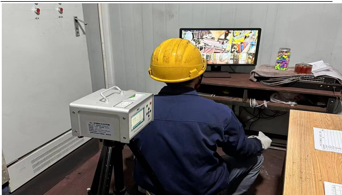
制粉车间二控制室岗位
