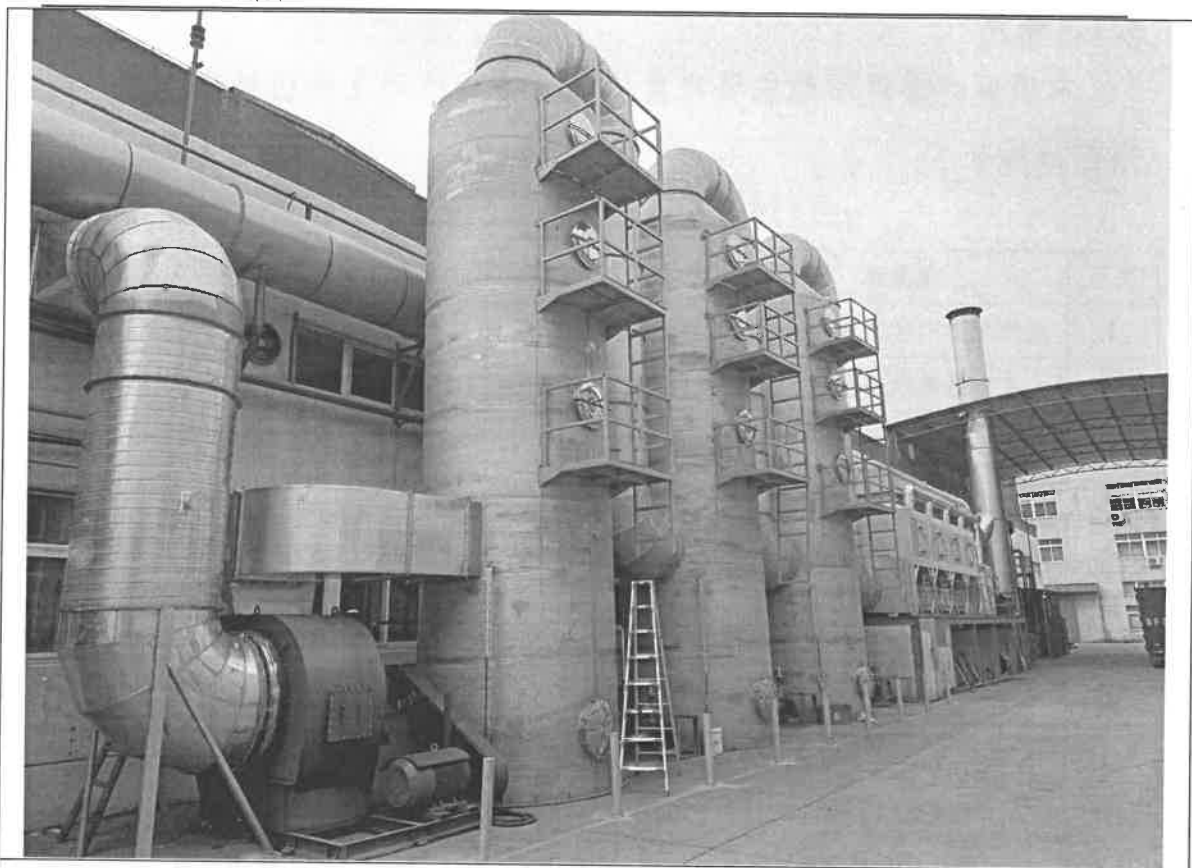
三级水喷淋+干式过滤+活性炭吸附脱附+催化燃烧
