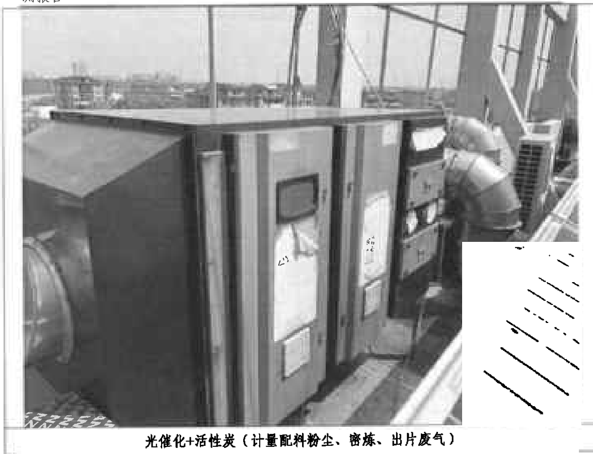
图 4-3 废气治理现场相关照片
