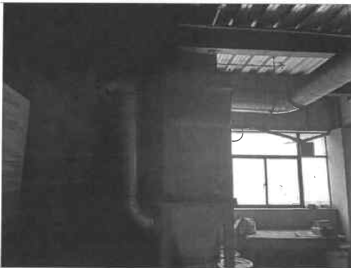
布袋除尘（计量配料粉尘、密炼废气）
