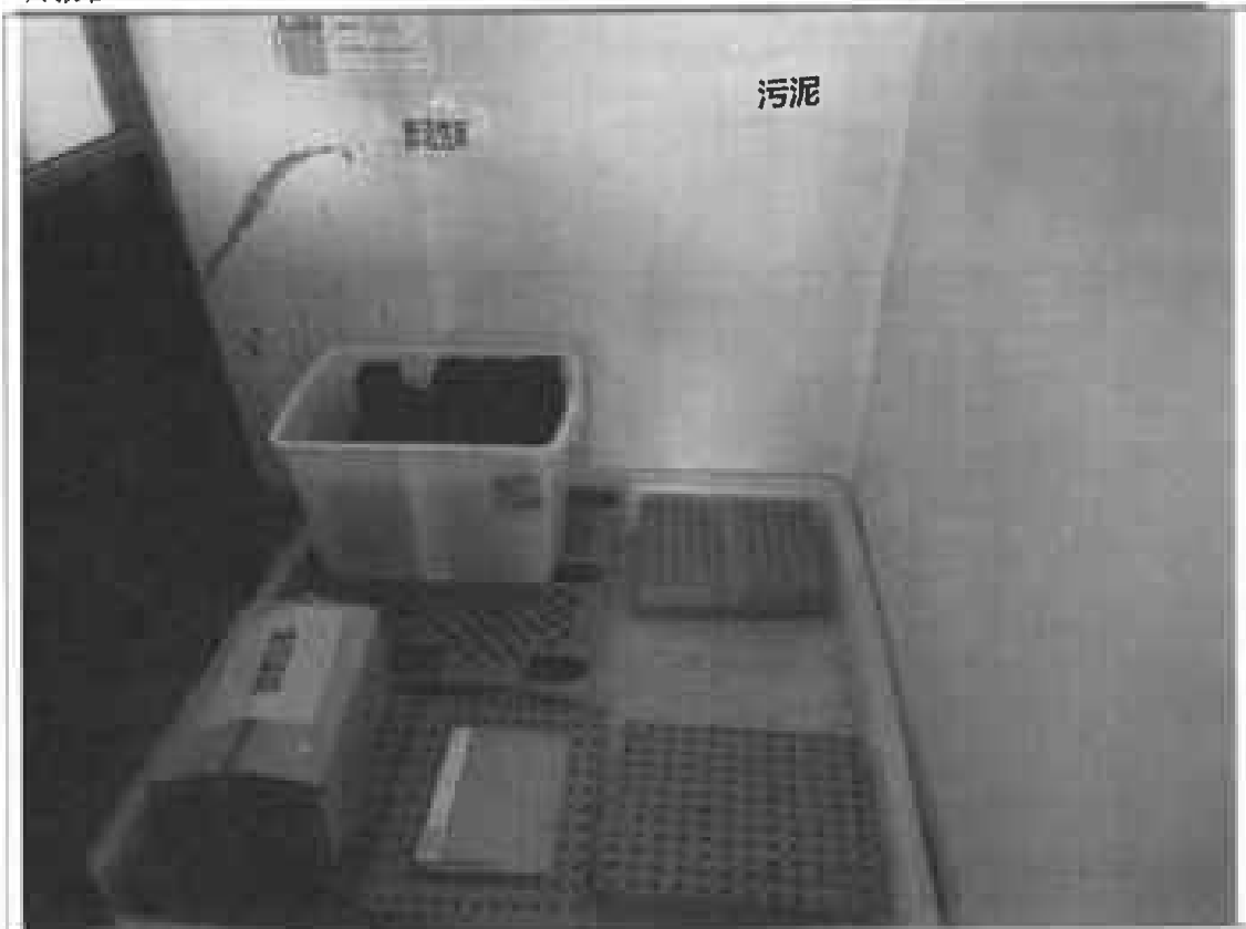
危废仓库内部
