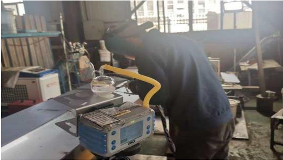
生产车间电焊岗位
