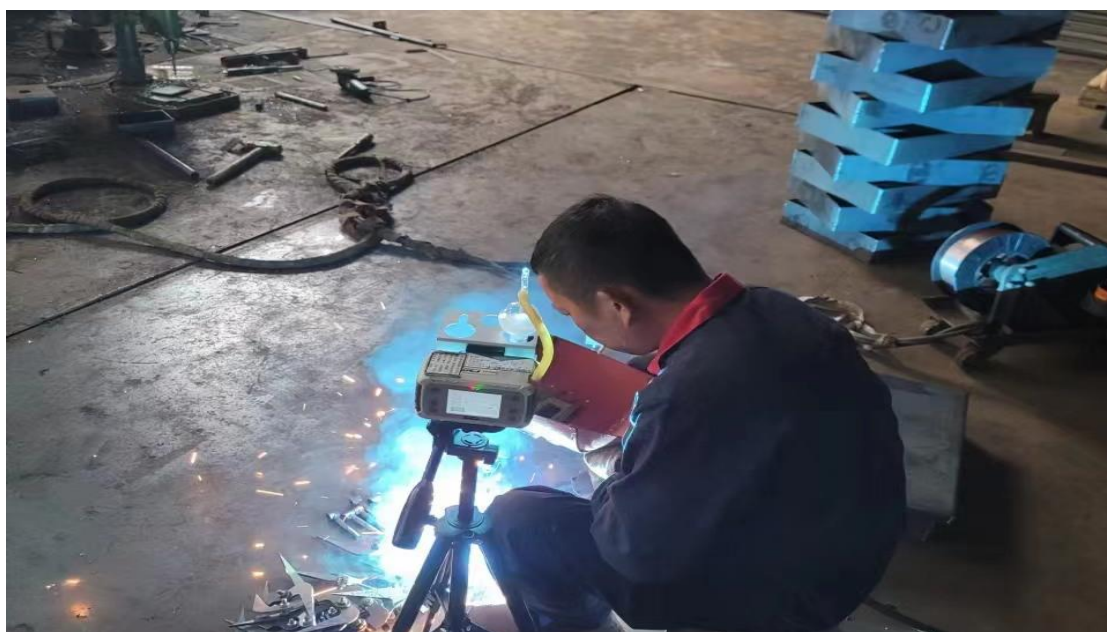
环保车间电焊岗位
