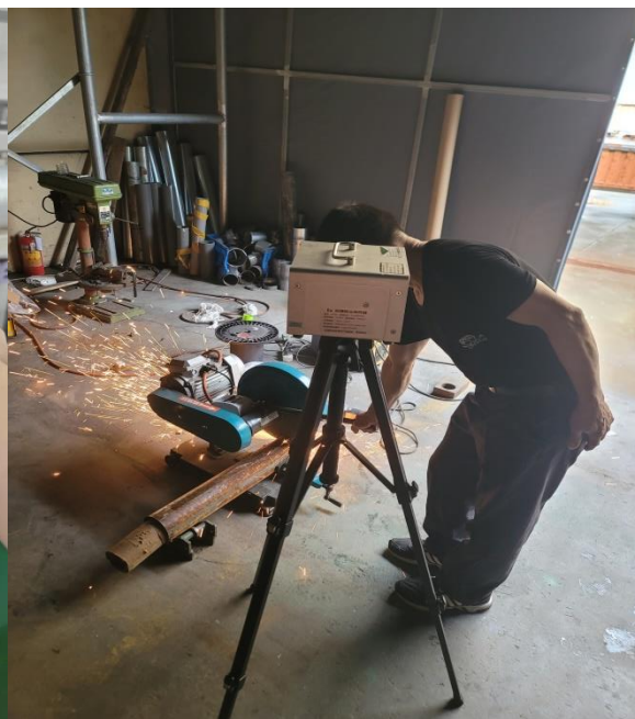
机修车间切割岗位
