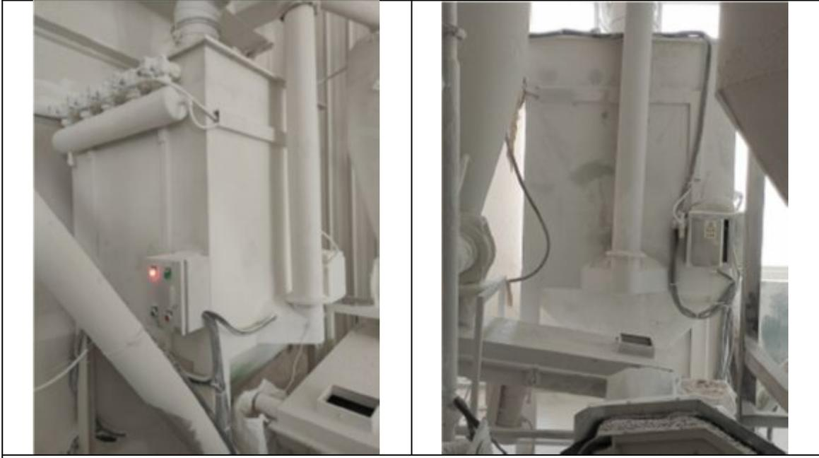
打粉废气布袋除尘装置
