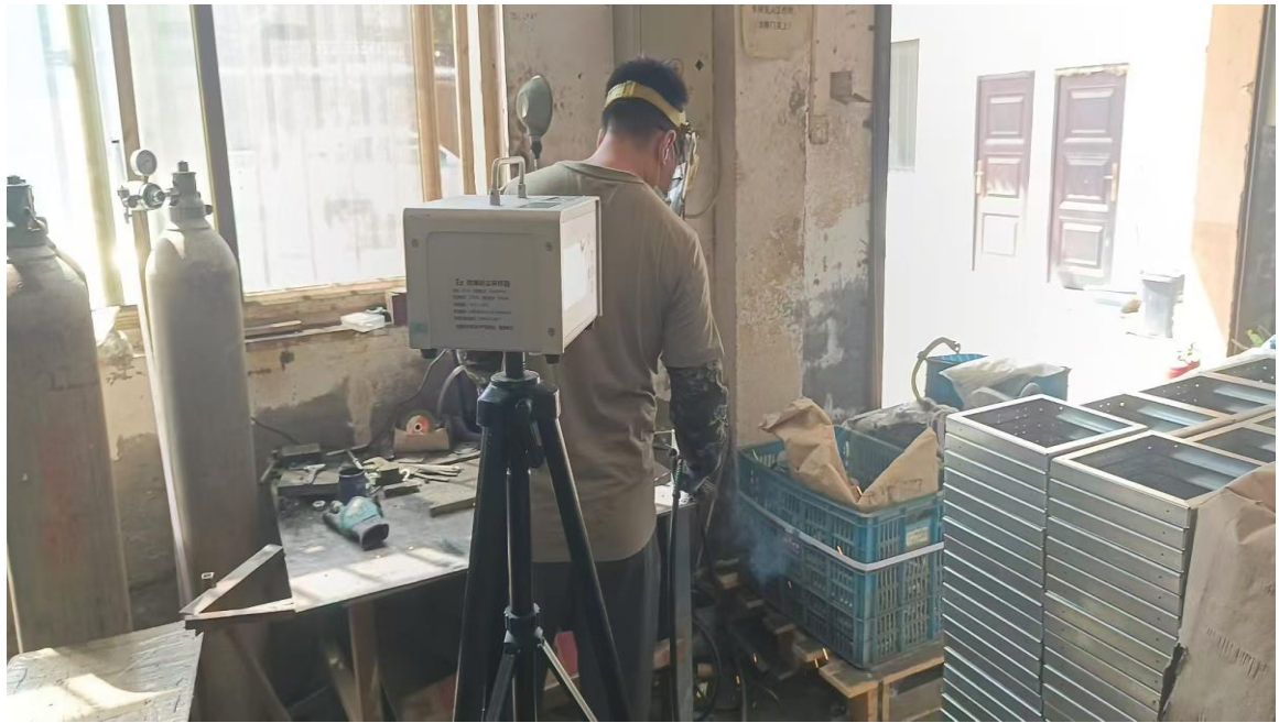
钣金车间电焊岗位
