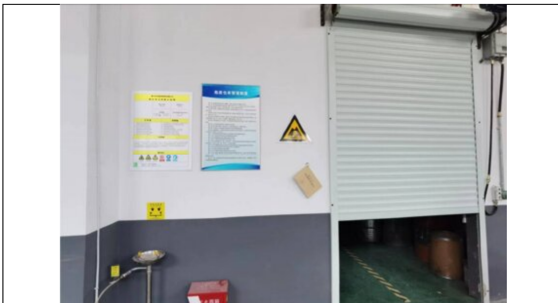
危废仓库外部照片
