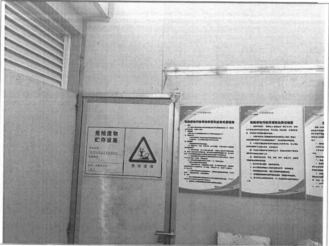
危废仓库外部
