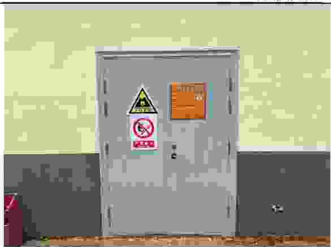
危废仓库外部
