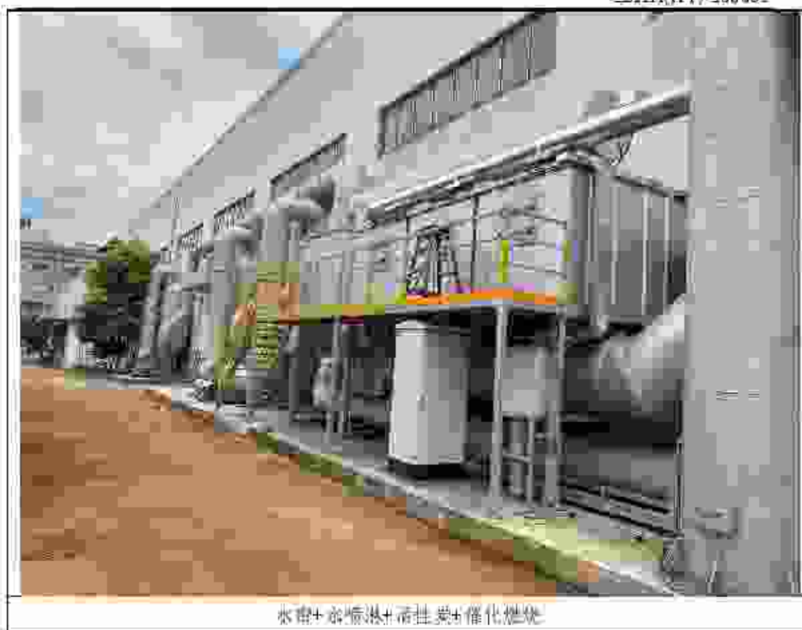
图 4-3 企业废气治理现场相关照片
