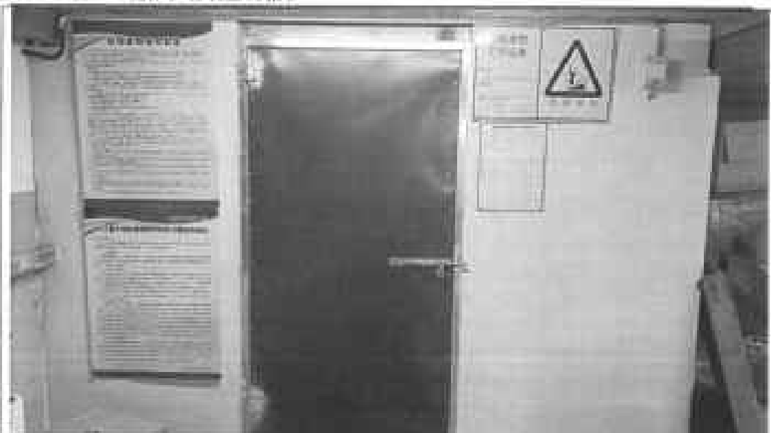
危废仓库外部
