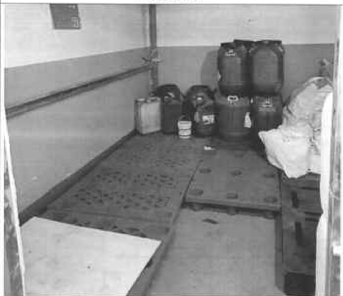
危废仓库内部
