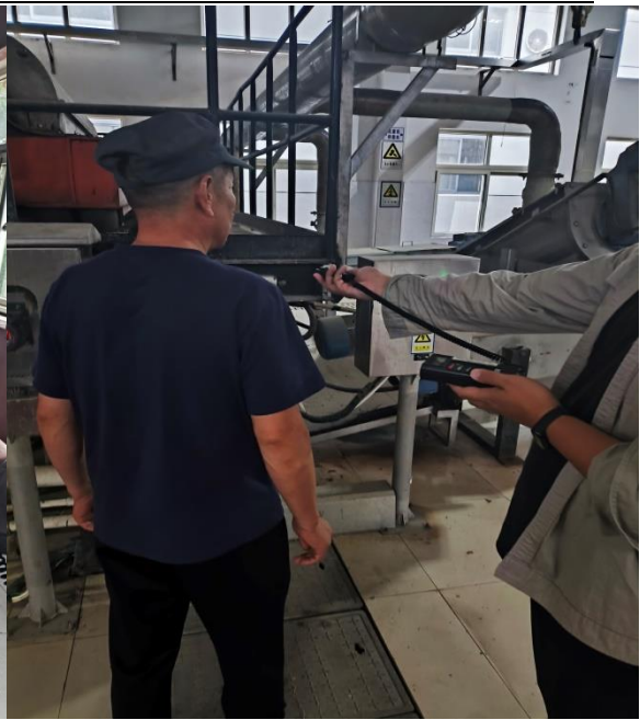
一、二期脱水机房岗位
