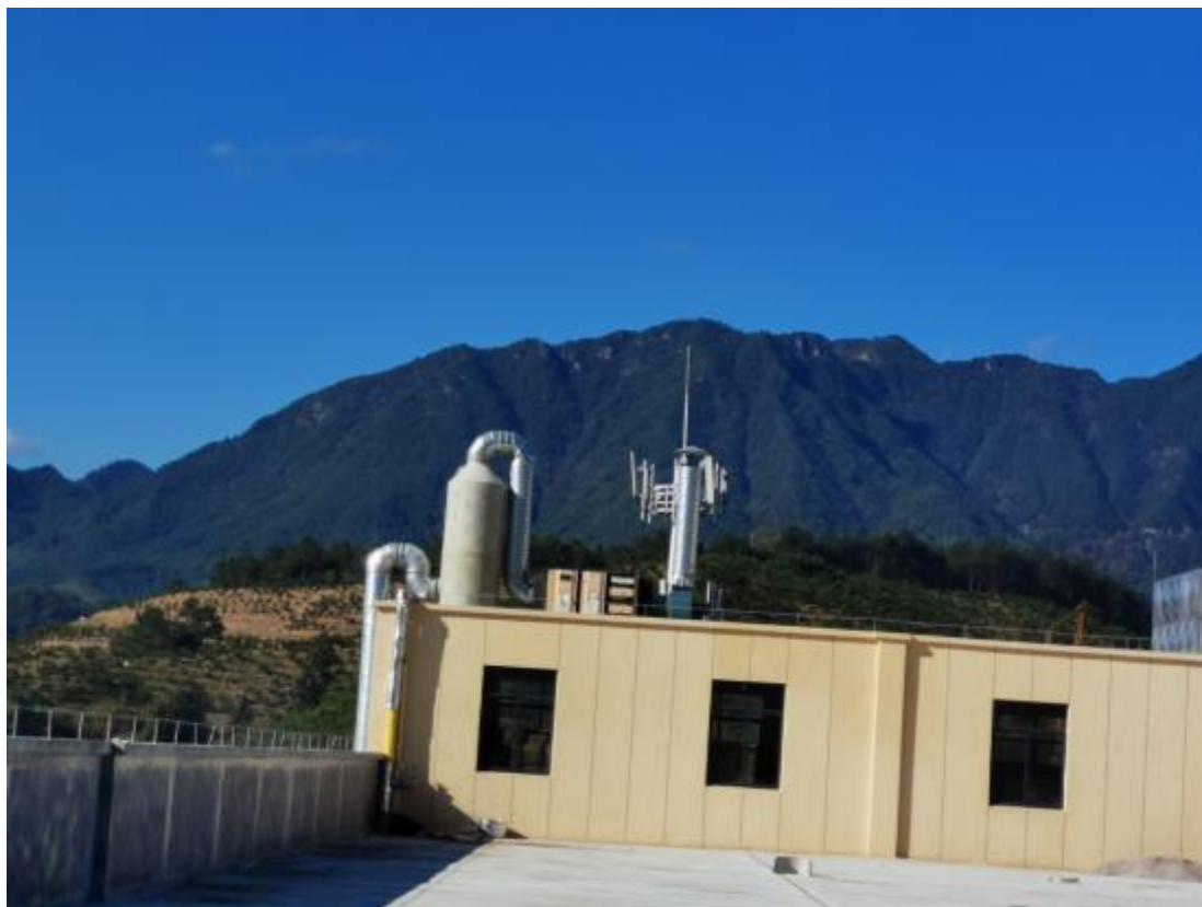
2#喷漆处理设备
