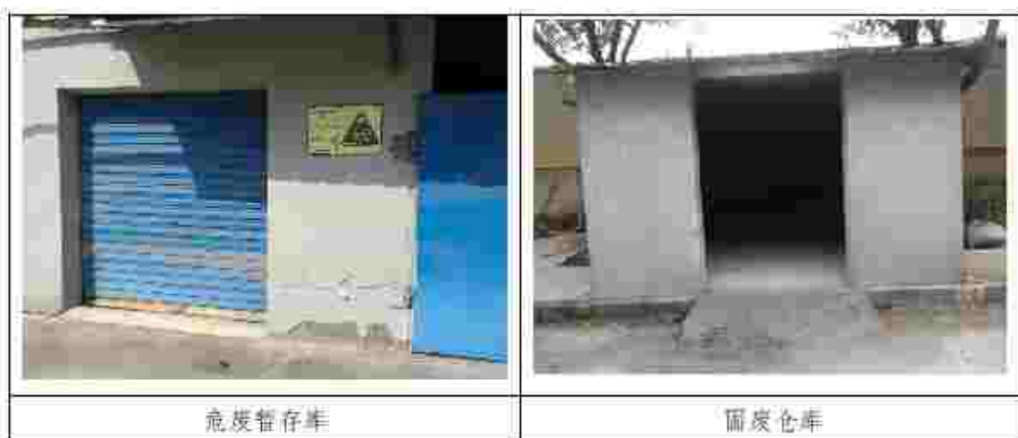
图 4-6 固废暂存库现场照片
