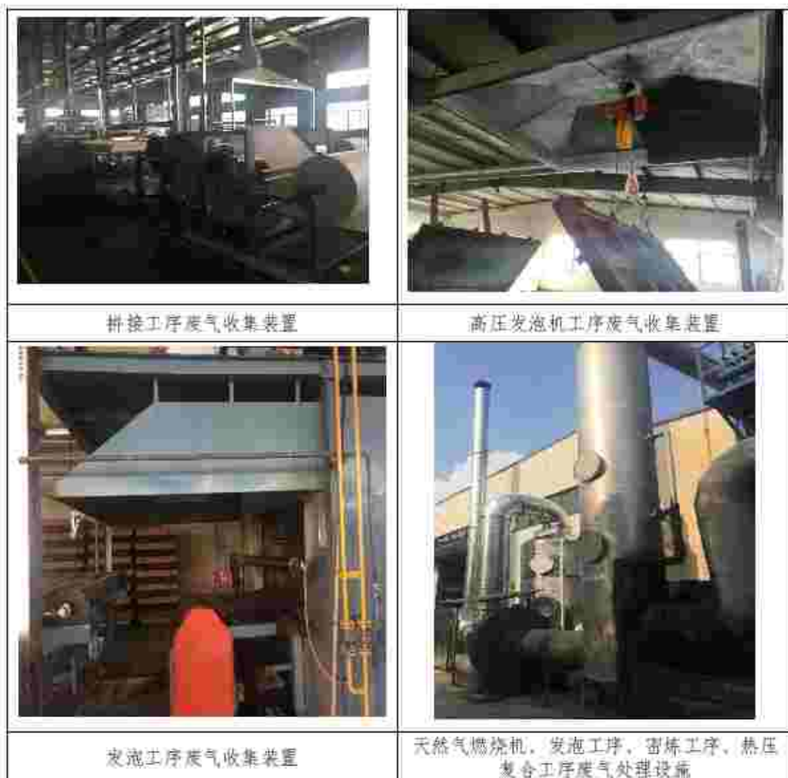
图 4-5 企业废气治理现场相关照片
