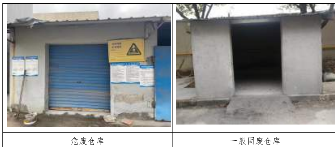
图 4-8 固废暂存库现场照片
