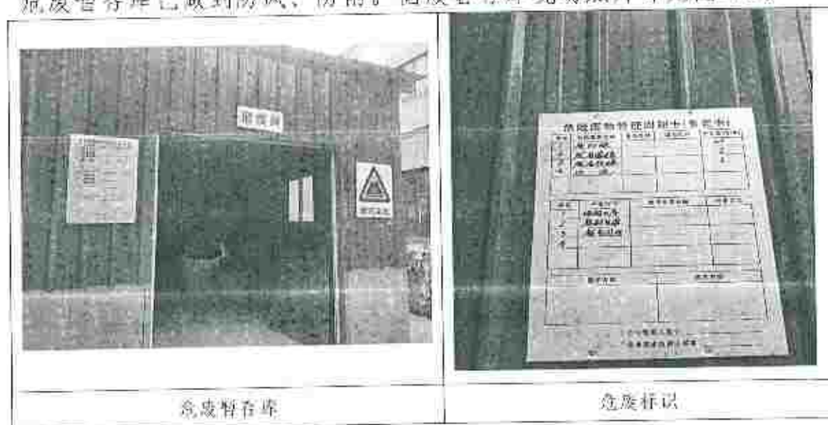
图 4-6 固废暂存库现场照片
