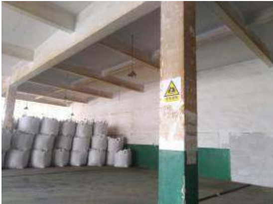
危废仓库内部
