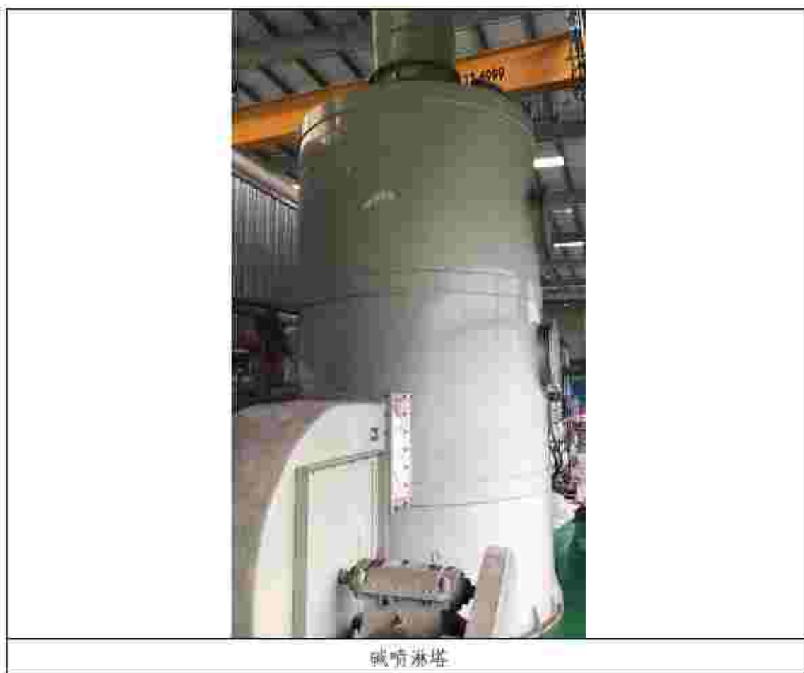
图 4-5 废气处理设施图
